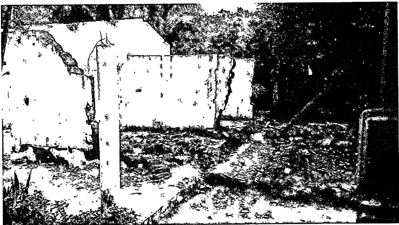
FOTO 06: Casa destruída pela chuva, Povoado Agua Rica, dia 19/03/2020, Coordenadas: (Longitude UTM: 719912.61 m E; Latitude UTM: 9593018.63 m S; Zona: 23 M)
