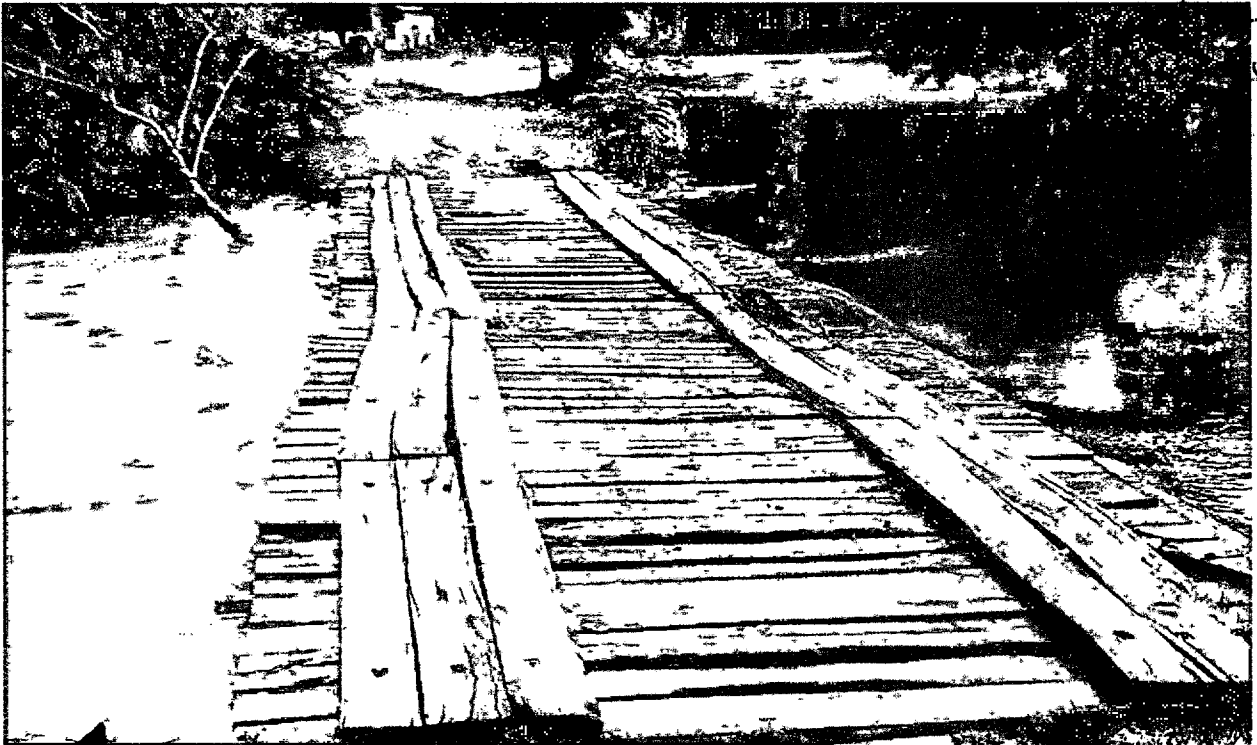
FOTO 09: Ponte de ligação do povoado Claudio para o povoado Jibóia, quase submersa, necessitando de reparos, dia 19/03/2020, Coordenadas: (Latitude: 3° 32' 54,001" S; Longitude: 42° 58' 48,01" W; Altitude: 51)
