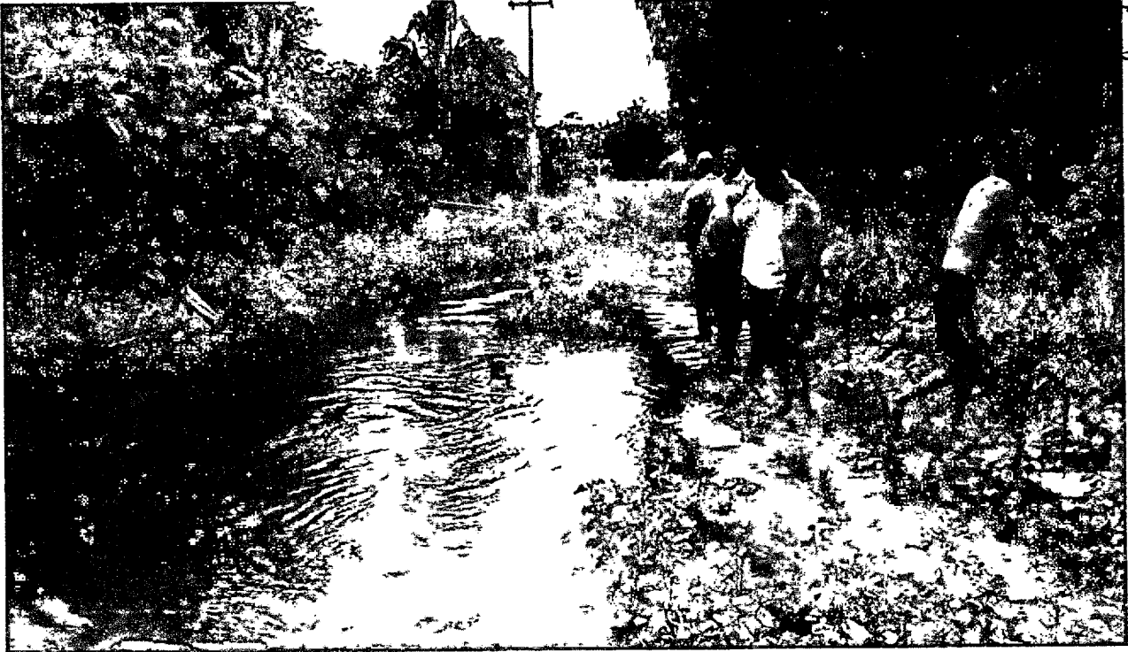
FOTO 15: Estrada necessitando construção de bueiro, rota utilizada pelo ônibus escolar, Povoado Rumo, dia 19/03/2020, Coordenadas: (Latitude: 3° 25' 0,266" S; Longitude: 43° 12' 3,202" W; Altitude: 29)
