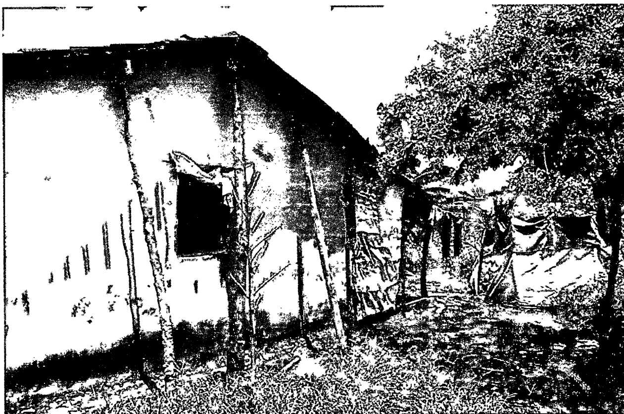
FOTO 38: Casa com risco de desabamento, Zona Urbana do município, Bairro Cinco Estrelas, dia 21/03/2020, Coordenadas: (Latitude: 3°41'0.33" S; Longitude: 43° 6'20.13" O; Altitude: 63,57 m)
