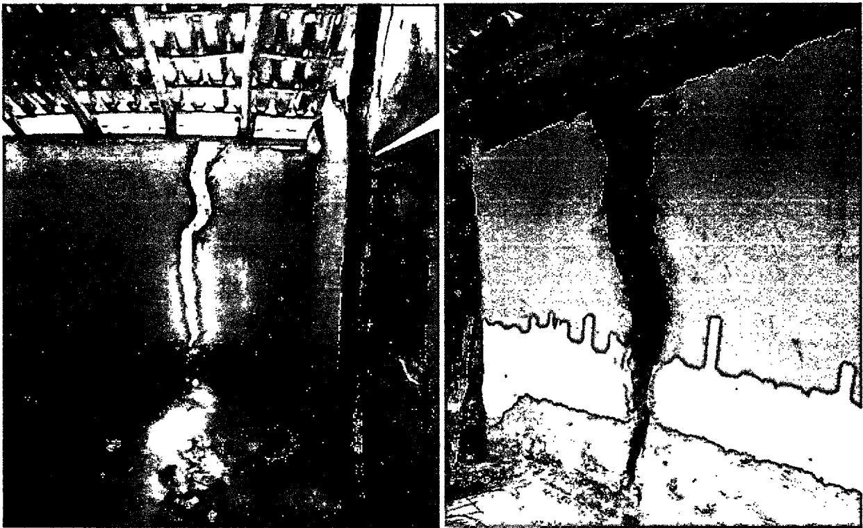
FOTO 42: Casa destruída, terreno cedeu e a parede abriu, Povoado Bebedouro, dia 20/03/2020
