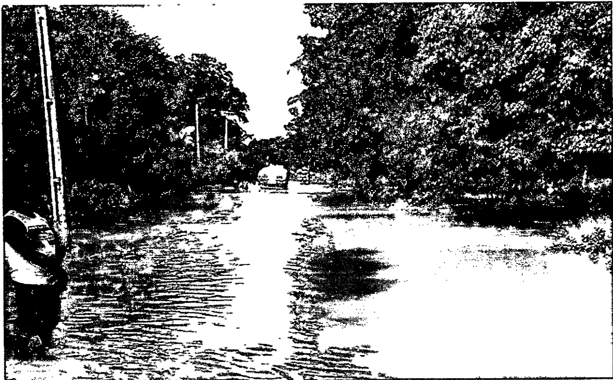
FOTO 28: Estrada alagada, estrada necessita reparos e reconstrução de bueiro, Povoado Poços, dia 20/03/2020, Coordenadas: (Latitude: 3°33'44.18" S; Longitude: 43° 3'52.08" O; Altitude: 72m)
