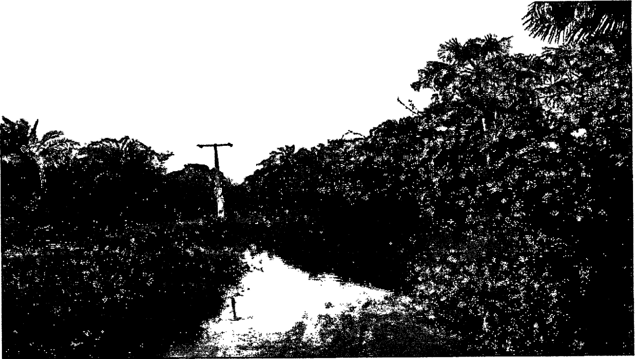
FOTO 29: Estrada alagada, necessitando a construção de bueiro, Povoado São José, dia 20/03/2020, Coordenadas: (Latitude: 3°23'33.76"S; Longitude: 43° 1'13.85"O; Altitude: 84m)
