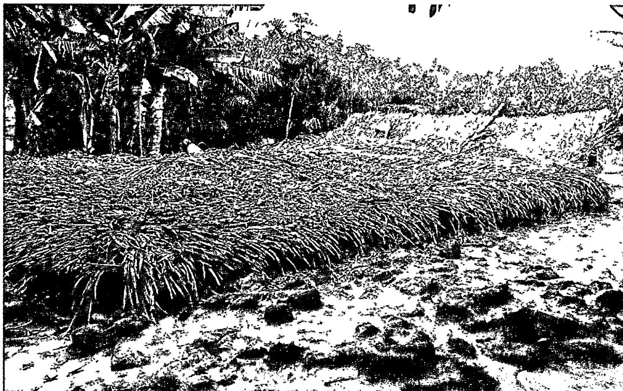
FOTO 04: Casa destruída, Povoado Sapucaia, dia 19/03/2020
