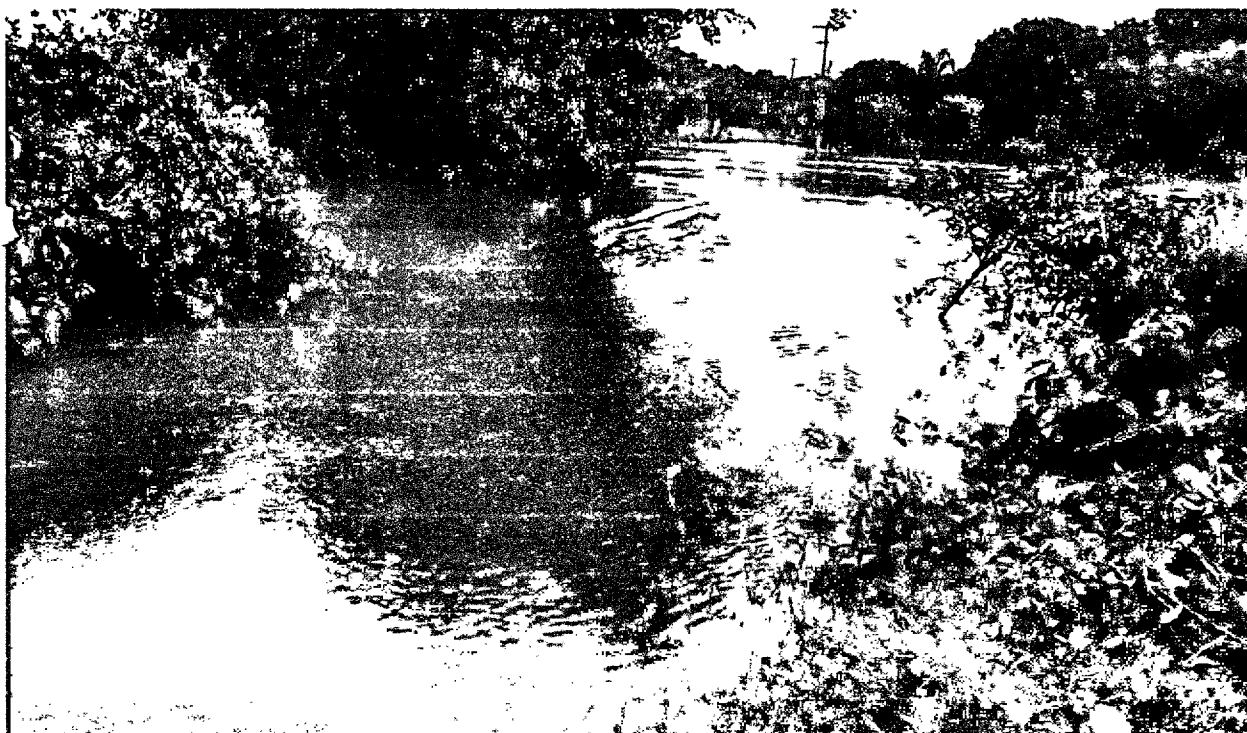
FOTO 26: Ponte de ligação ao povoado campestre submersa, Povoado Campestre, dia 20/03/2020, Coordenadas: (Latitude: 3° 32' 56,94" S; Longitude: 43° 8' 18,111" W; Altitude: 38 m)
