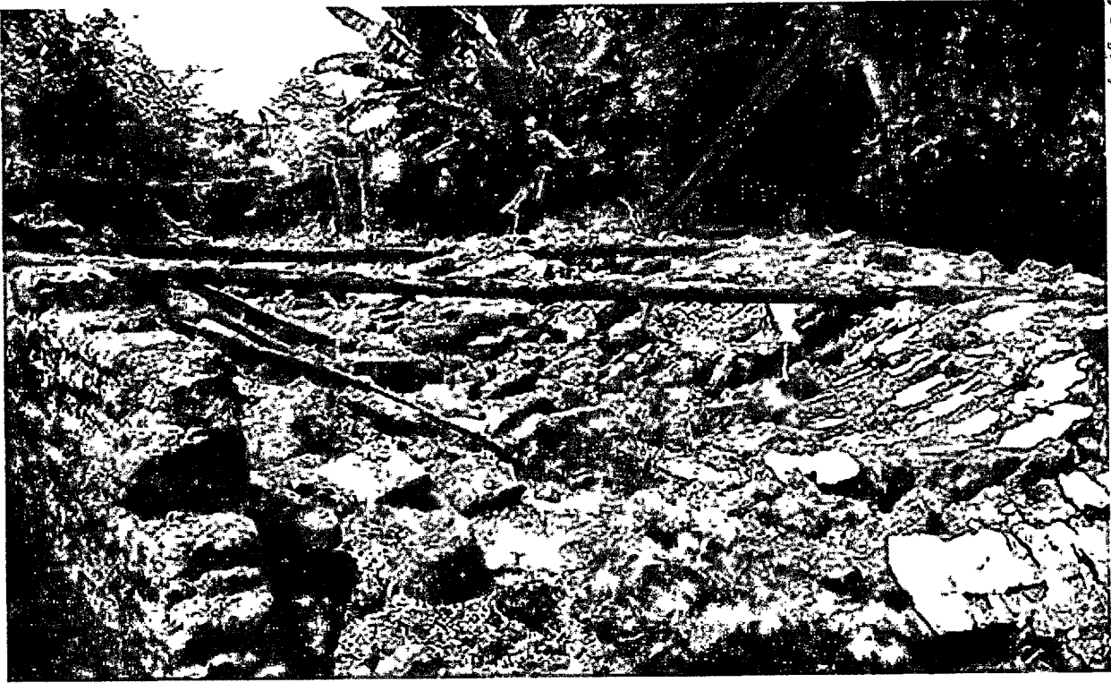
FOTO 41: Casa destruída, Povoado Bebedouro, dia 20/03/2020
