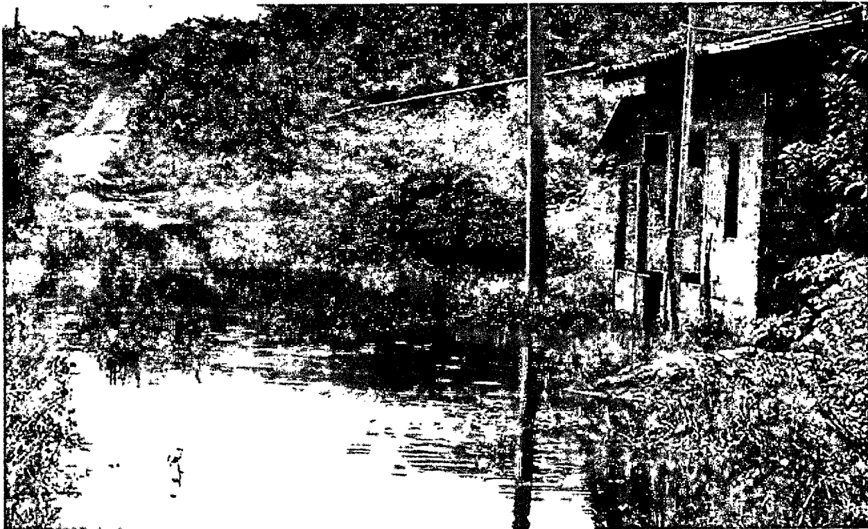
FOTO 35: Casa alagada, Zona Urbana do município, Bairro Cinco Estrelas, dia 21/03/2020, Coordenadas: (Latitude: 3°40'57.51"S; Longitude: 43° 6'23.25" O; Altitude: 64 m)
