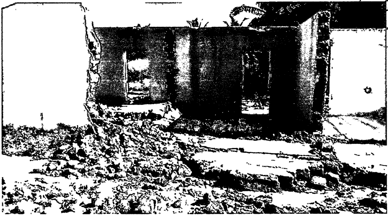
FOTO 41: Casa destruída, Povoado Bebedouro, dia 20/03/2020
