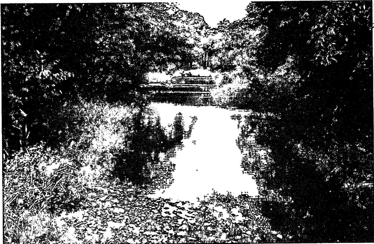
FOTO 05: Ponte submersa com danos causados pelo volume do rio, Povoado Sapucaia, dia 19/03/2020, Coordenadas: (Latitude: 3°43'16,936" S; Longitude: 43°0'42,259" W; Altitude: 56)
