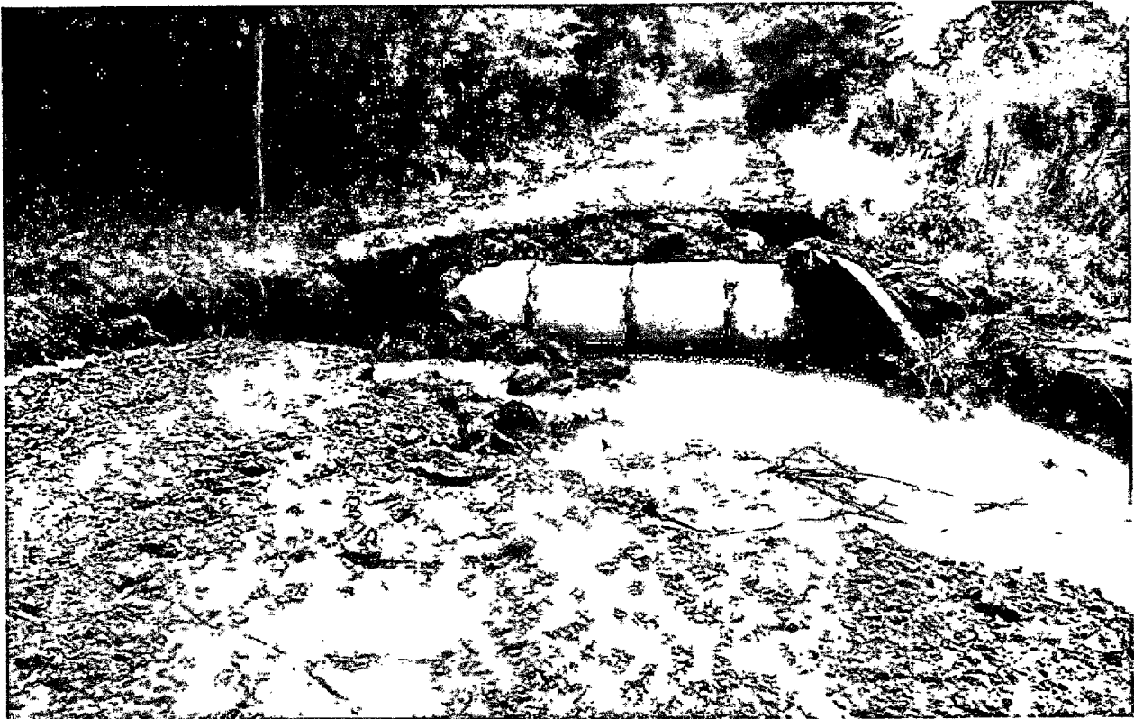
FOTO 30: Estrada destruída, necessitando a construção de bueiro, Povoado São Gonçalo, dia 20/03/2020, Coordenadas: (Latitude: 3°27'44.78"S; Longitude: 43° 2'56.55"O; Altitude: 81m)
