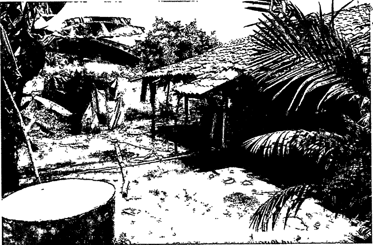
FOTO 39: Casa com risco de desabamento, Zona Urbana do município, Bairro Cinco Estrelas, dia 21/03/2020, Coordenadas: (Latitude: 3°41'0.33" S; Longitude: 43° 6'20.13" O; Altitude: 63,57 m)
