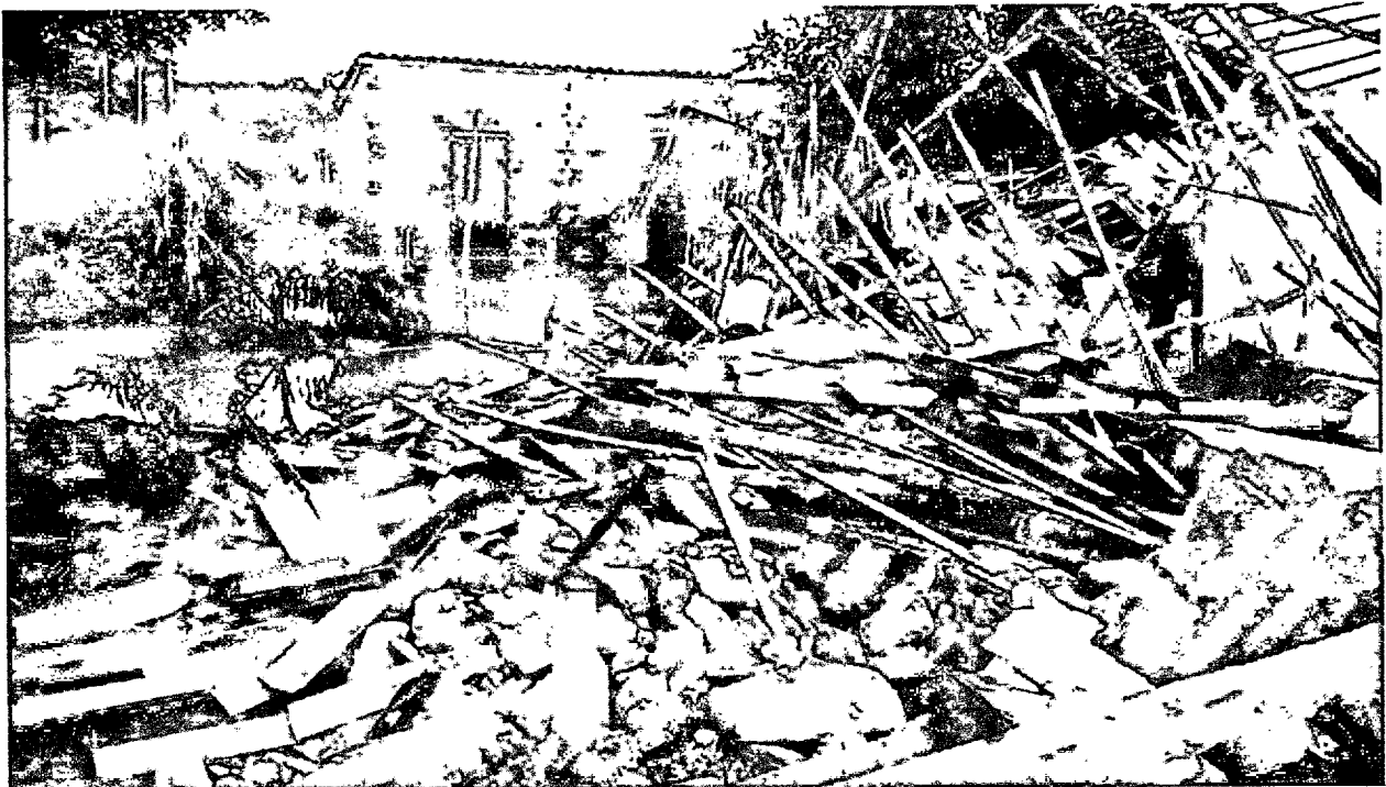
FOTO 40: Casa destruída, Zona Urbana do município, Bairro Cinco Estrelas, dia 21/03/2020, Coordenadas: (Latitude: 9592813.00 m S; Longitude: 710286.00 m E; Altitude: 57 m)
