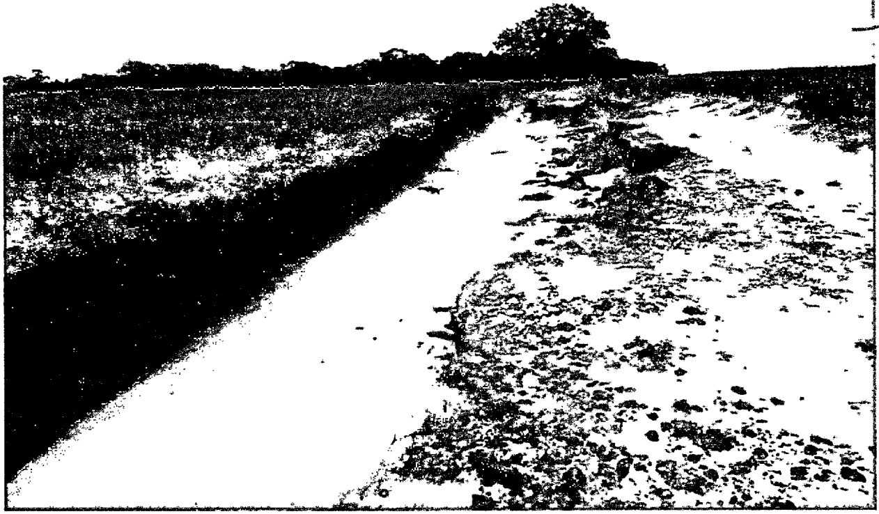
FOTO 33: Estrada destruída, necessitando a reconstrução, Povoado São Gonçalo, dia 20/03/2020, Coordenadas: (Latitude: 3°29'6.24"S; Longitude: 43° 2'18.78" O; Altitude: 104m)
