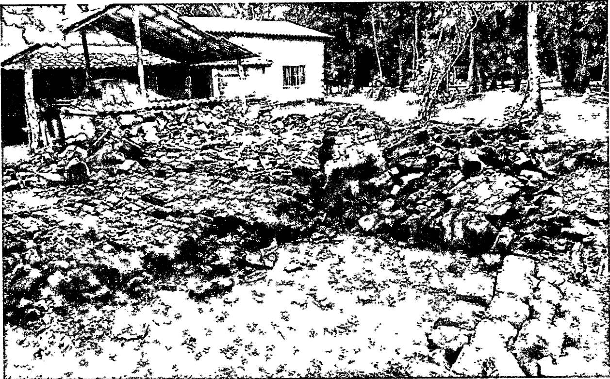
FOTO 16: Casa destruída pela ação das chuvas, Povoado Rumo, dia 19/03/2020, Coordenadas: (Latitude: 3° 25' 0,266" S; Longitude: 43° 12' 3,202" W; Altitude: 29)
