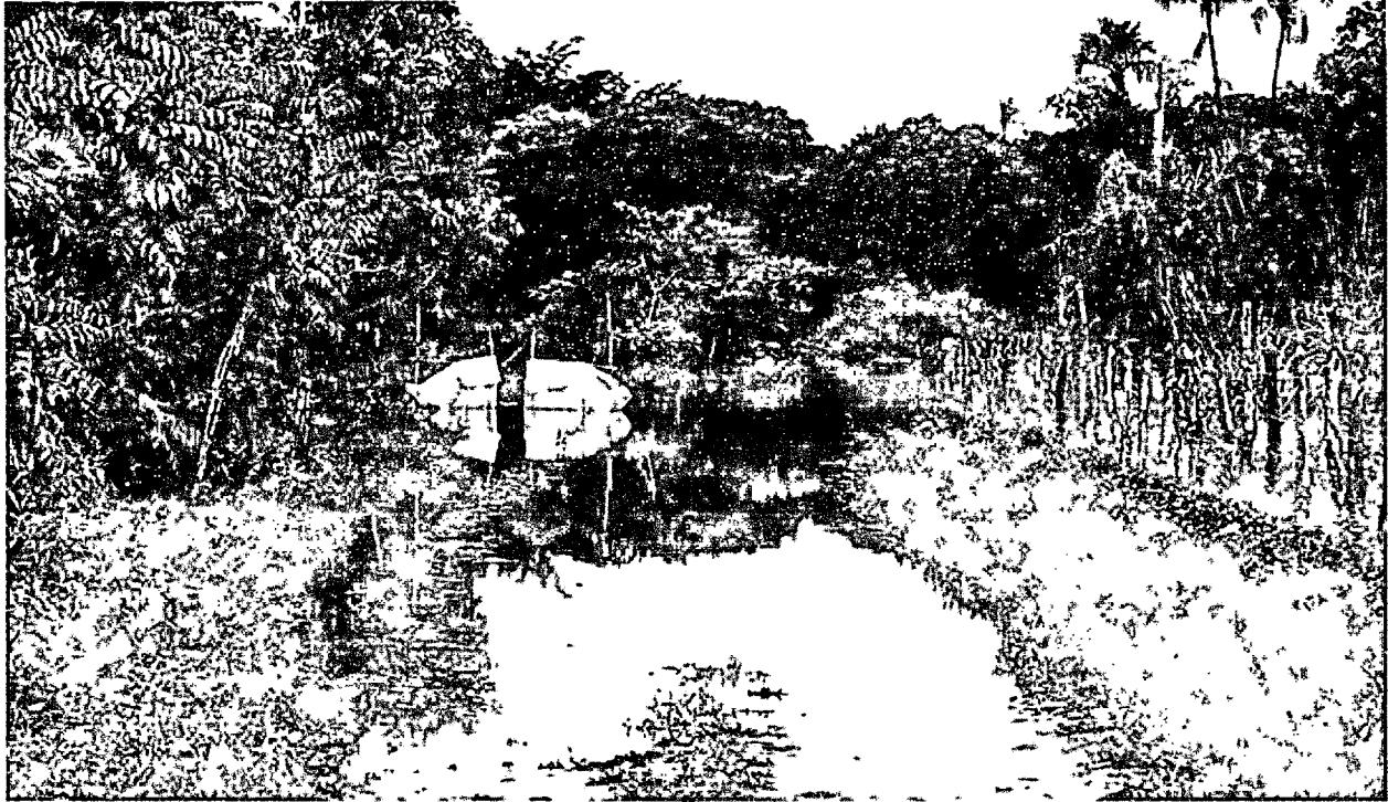
FOTO 44: Registro de estrada de acesso ao povoado Japão alagada causada pela chuva intensa, Povoado Bandeira, dia 25/04/2020, Coordenadas: (Latitude: 3°30'42" S; Longitude: 43°1'0" W; Altitude: 70m)
