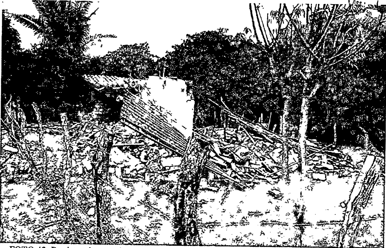
FOTO 42: Registro de casa destruída causada pela intensidade da chuva, Povoado Claudio, dia 25/04/2020, Coordenadas: (Latitude: 3°31'0" S; Longitude: 42°58'59" W; Altitude: 70m)
