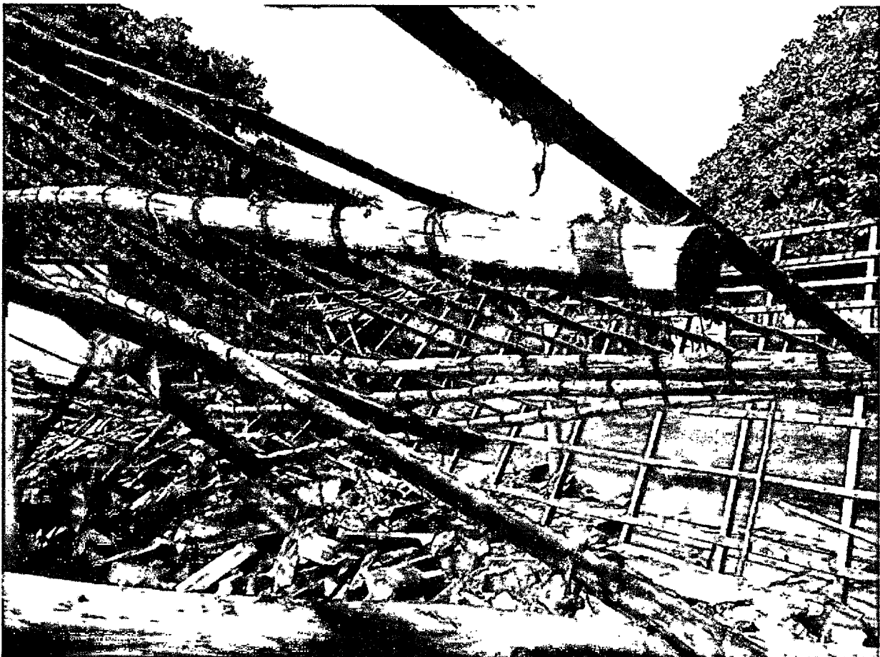
FOTO 04: Registro de casas destruídas pela chuva intensa, Povoado Carnaúba, dia 23/04/2020, Coordenadas: (Latitude: 3°36'28" S; Longitude: 42°59'42" W; Altitude: 70m)
