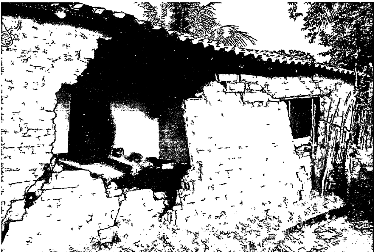
FOTO 16: Registro de casa parcialmente destruída e com estrutura abalada resultado da chuva intensa, Povoado Recanto, dia 23/04/2020, Coordenadas: (Latitude: 3°35'43" S; Longitude: 42°59'54" W; Altitude: 70m)
