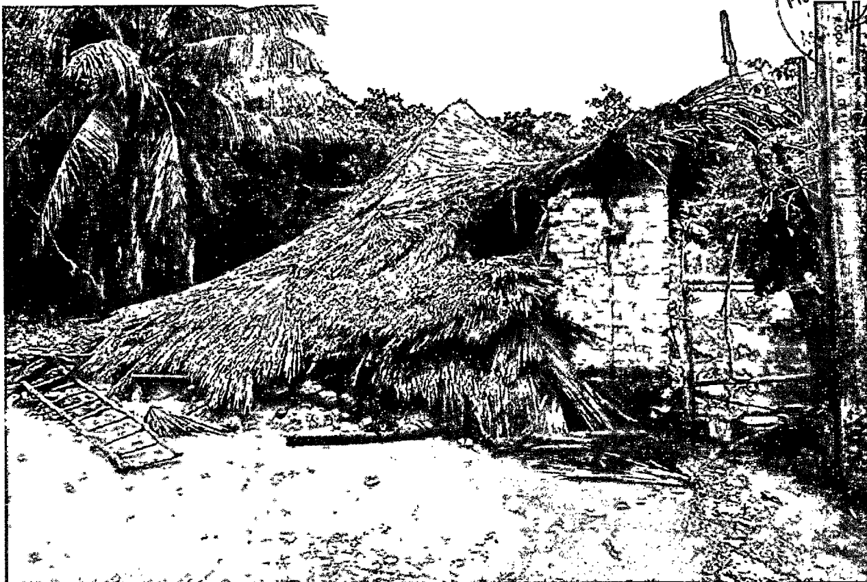
FOTO 19: Registro de casa destruída em local de alagamento causada pela chuva muito forte, Povoado Recanto, dia 23/04/2020, Coordenadas: (Latitude: 3°35'41" S; Longitude: 42°59'54" W; Altitude: 70m)
