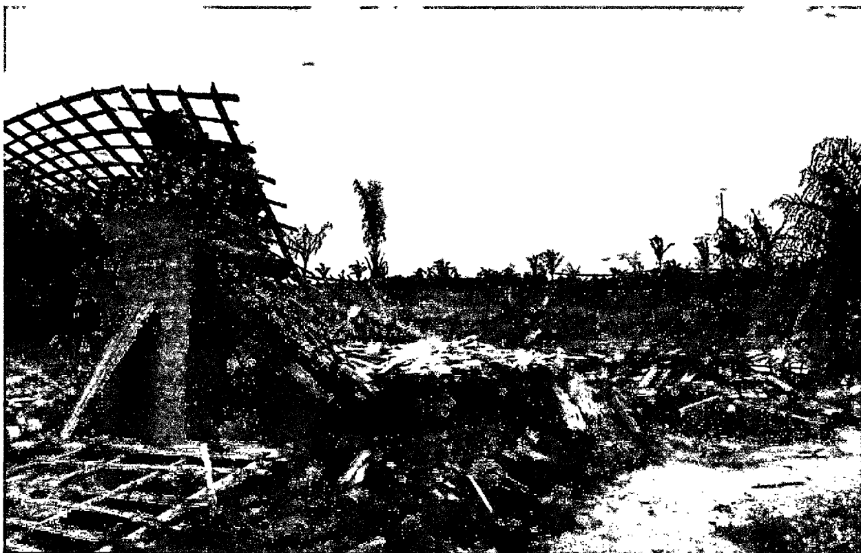
FOTO 10: Registro de casa destruída pela chuva intensa, Povoado Carnaúba, dia 23/04/2020, Coordenadas: (Latitude: 3°36'0" S; Longitude: 42°59'47" W; Altitude: 70m)
