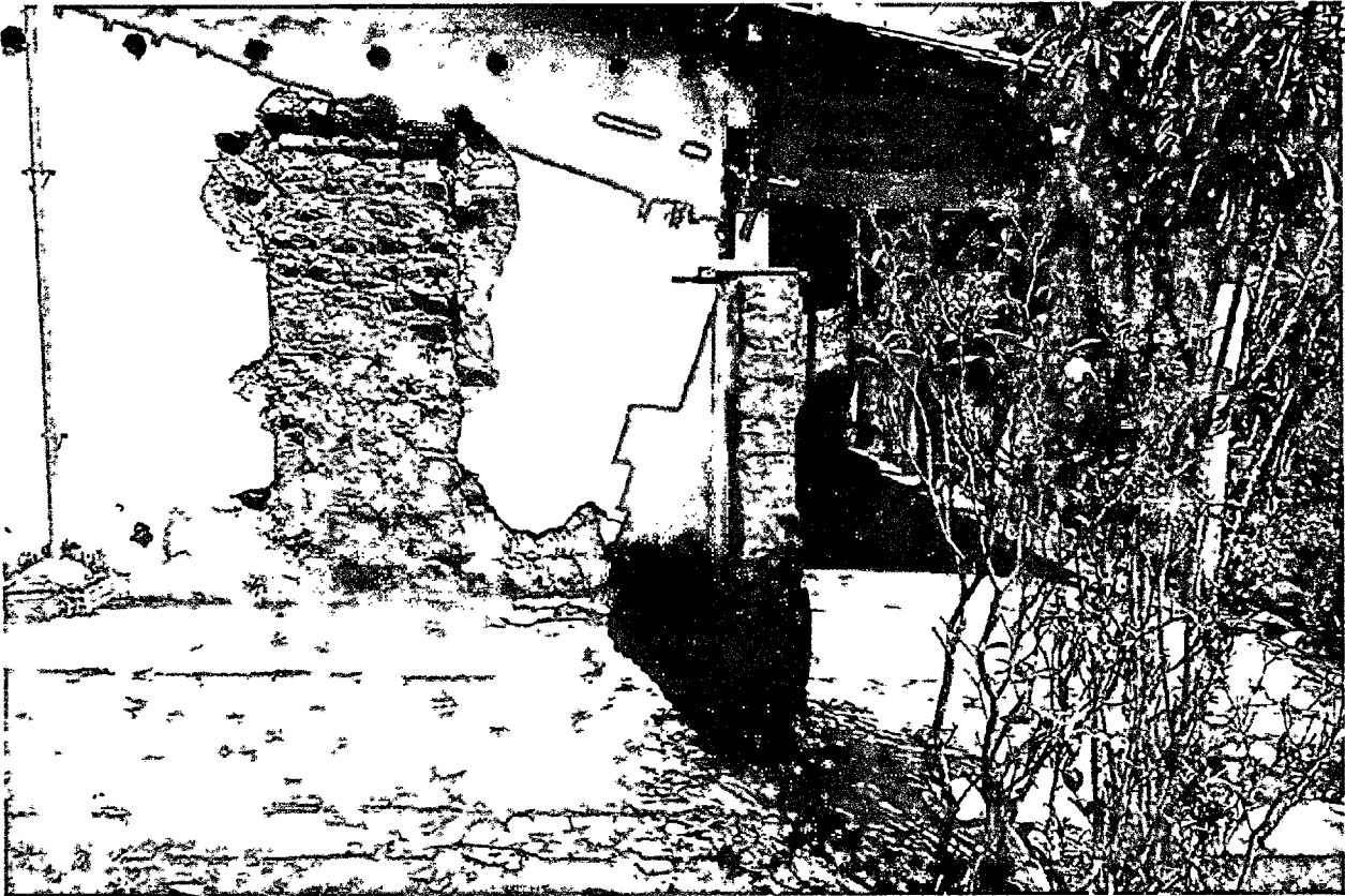
FOTO 63: Registro de casa parcialmente destruída e com estrutura abalada resultado da chuva intensa, Povoado Água Rica, dia 27/04/2020, Coordenadas: (Latitude: 3°41'51" S; Longitude: 43°1'12" W; Altitude: 80m)
