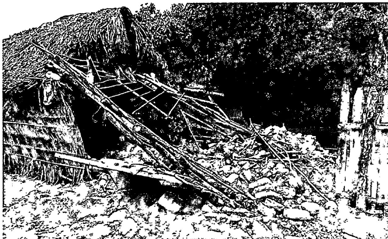
FOTO 35: Registro de casa desabada, Povoado Angical, dia 25/04/2020, Coordenadas: (Latitude: 3°31'44" S; Longitude: 43°2'52" W; Altitude: 60m)
