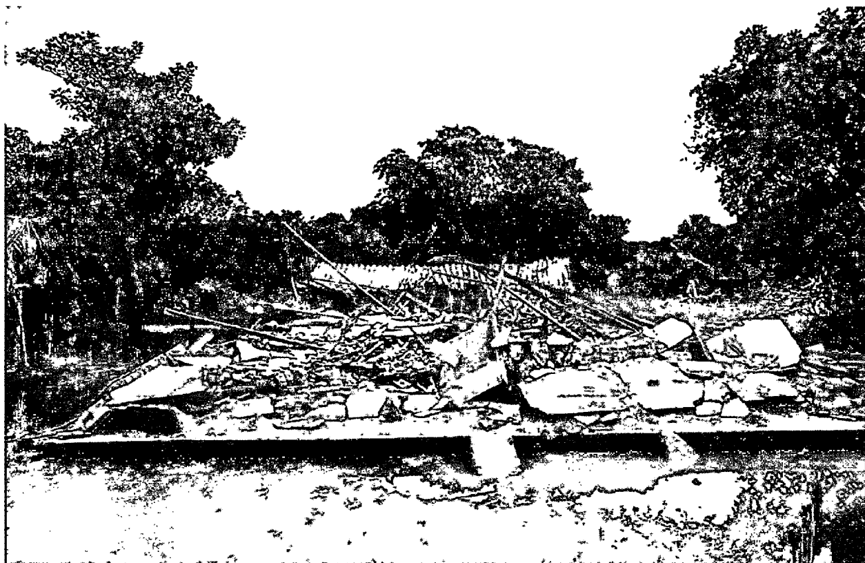
FOTO 18: Registro de casa destruída resultado da ação da chuva no local, Povoador Recanto, dia 23/04/2020, Coordenadas: (Latitude: 3°35'42" S; Longitude: 42°59'54" W; Altitude: 70m)
