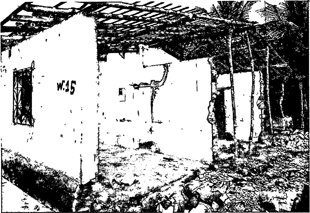
FOTO 21: Registro de casa destruída, Povoado Recanto, dia 23/04/2020, Coordenadas: (Latitude: 3°35'38" S; Longitude: 42°59'53" W; Altitude: 70m)
