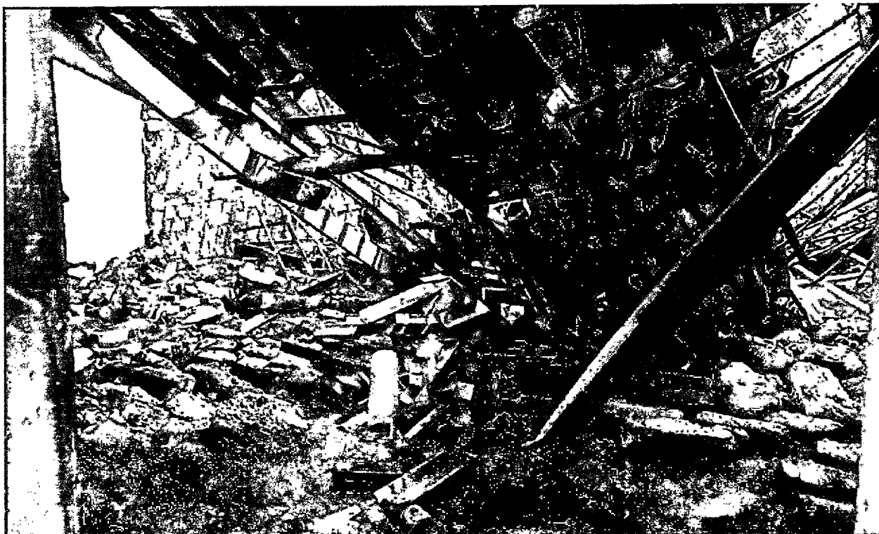
FOTO 30: Registro de casa com estrutura comprometida e telhado destruído ocasionado pela chuva muito forte, Povoado Riachinho, dia 24/04/2020, Coordenadas: (Latitude: 3°31'49" S; Longitude: 42°58'48" W; Altitude: 70m)
