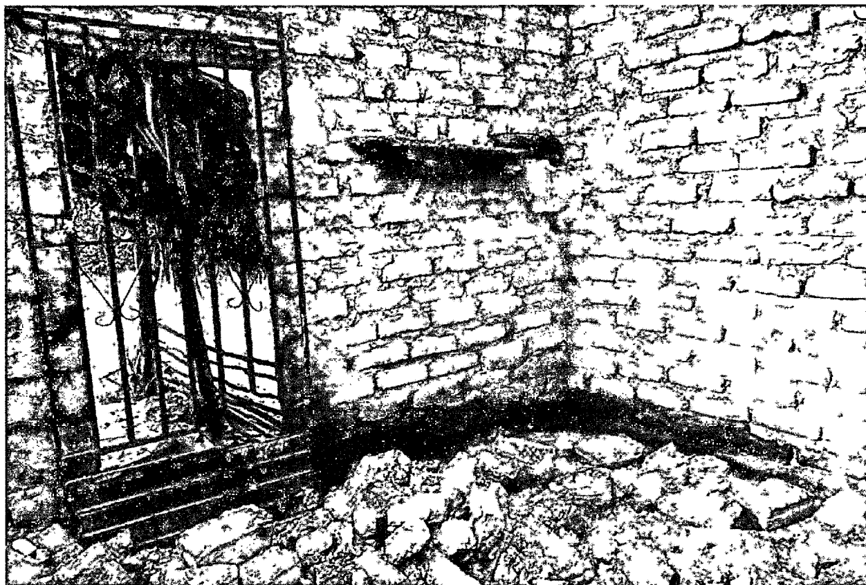
FOTO 32: Registro de casa destruída e invadida pela água da chuva intensa, Povoado Jiboia, dia 24/04/2020, Coordenadas: (Latitude: 3°30'35" S; Longitude: 43°0'4" W; Altitude: 60m)
