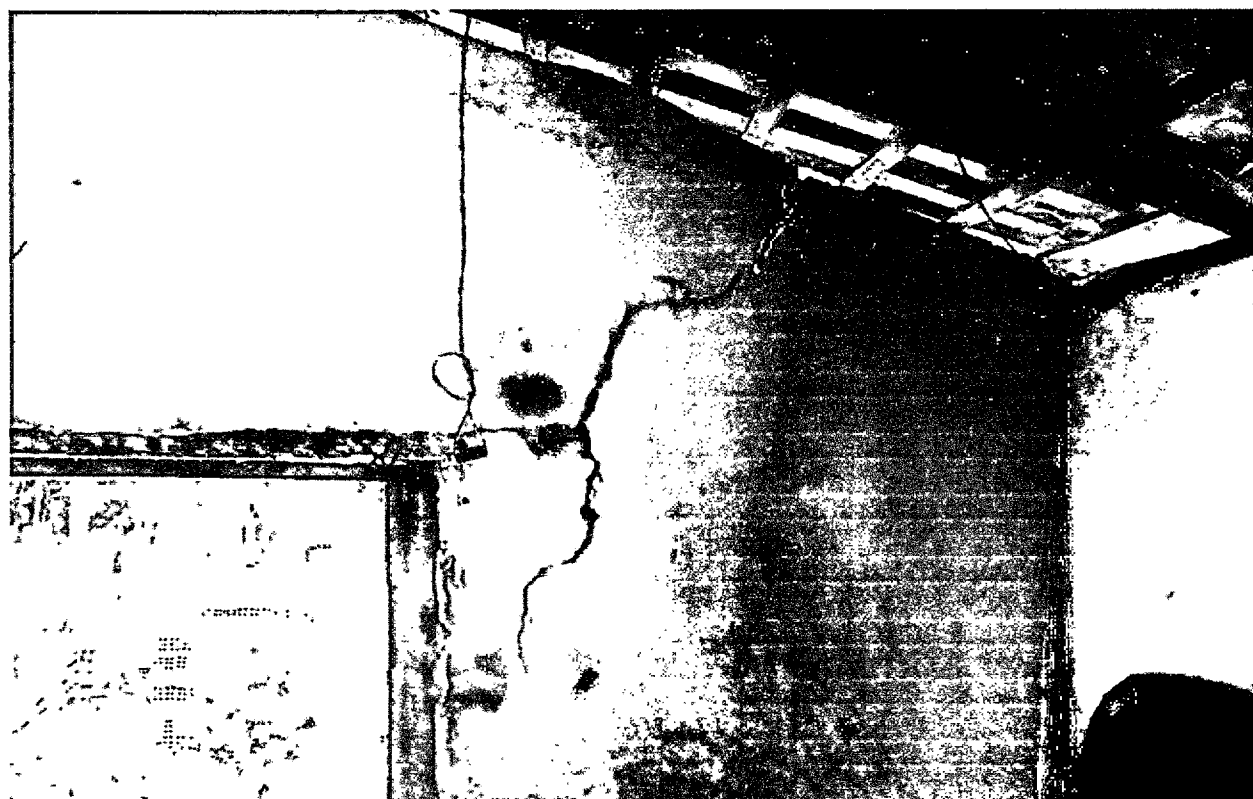
FOTO 37: Registro de casa comprometida com risco de desabamento, Povoado Angical, dia 25/04/2020, Coordenadas: (Latitude: 3°31'44" S; Longitude: 43°2'48" W; Altitude: 60m)
