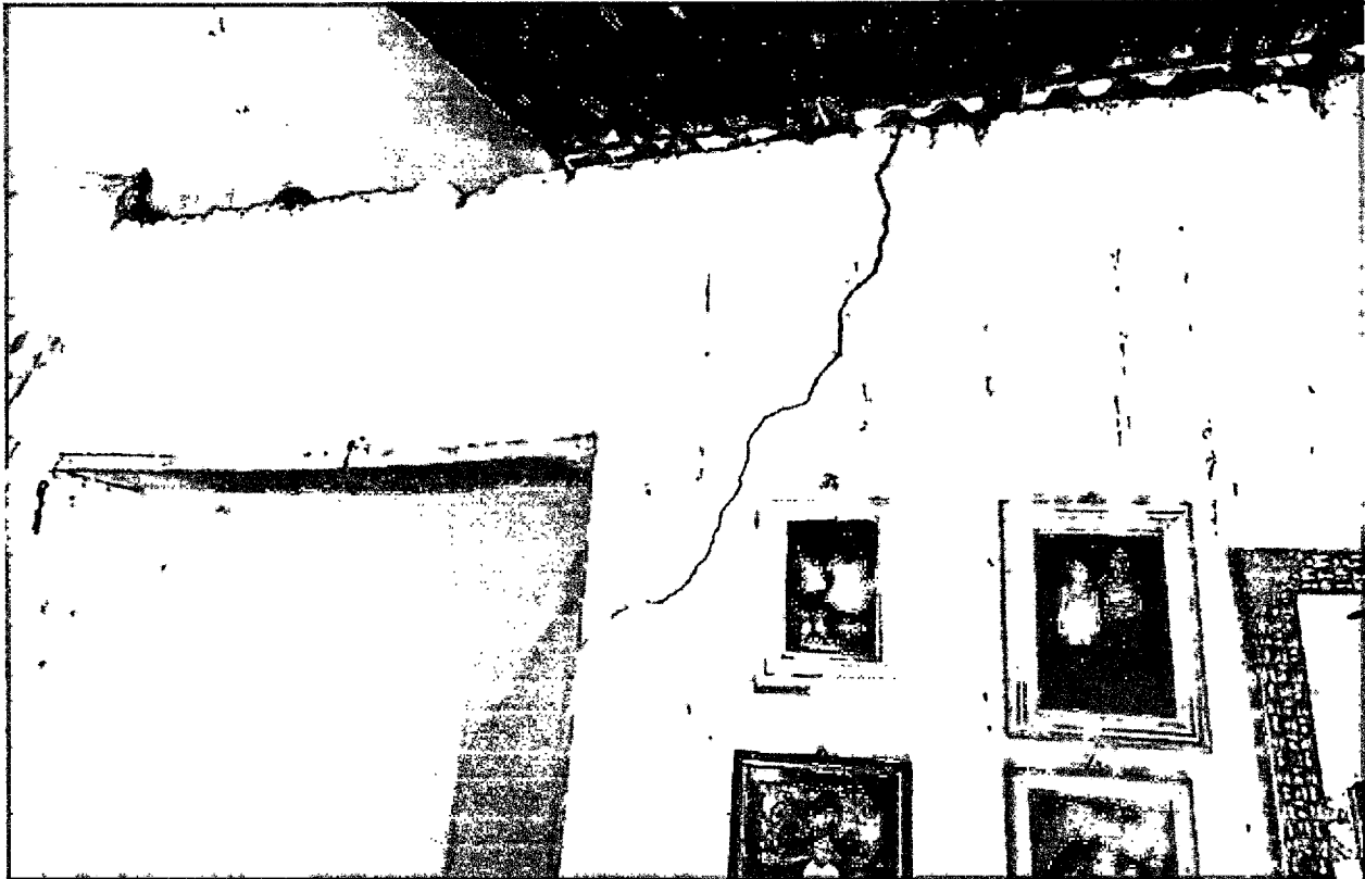
FOTO 67: Registro de casa com estrutura abalada apresentando fissuras, Povoado Recanto da Bisiu, dia 27/04/2020, Coordenadas: (Latitude: 3°42'6" S; Longitude: 43°0'38" W; Altitude: 80m)
