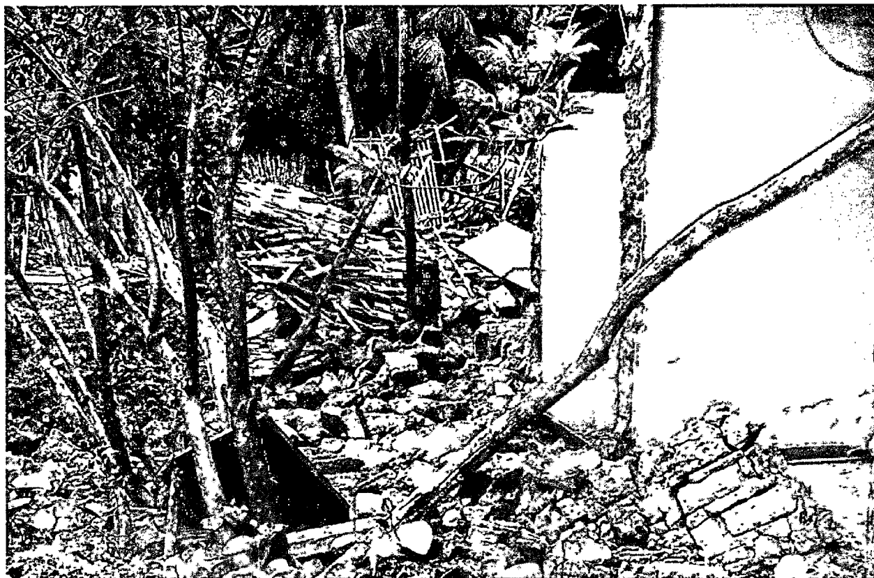
FOTO 36: Registro de casa destruída causada pela chuva intensa, Povoado Angical, dia 25/04/2020, Coordenadas: (Latitude: 3°31'44" S; Longitude: 43°2'49" W; Altitude: 60m)
