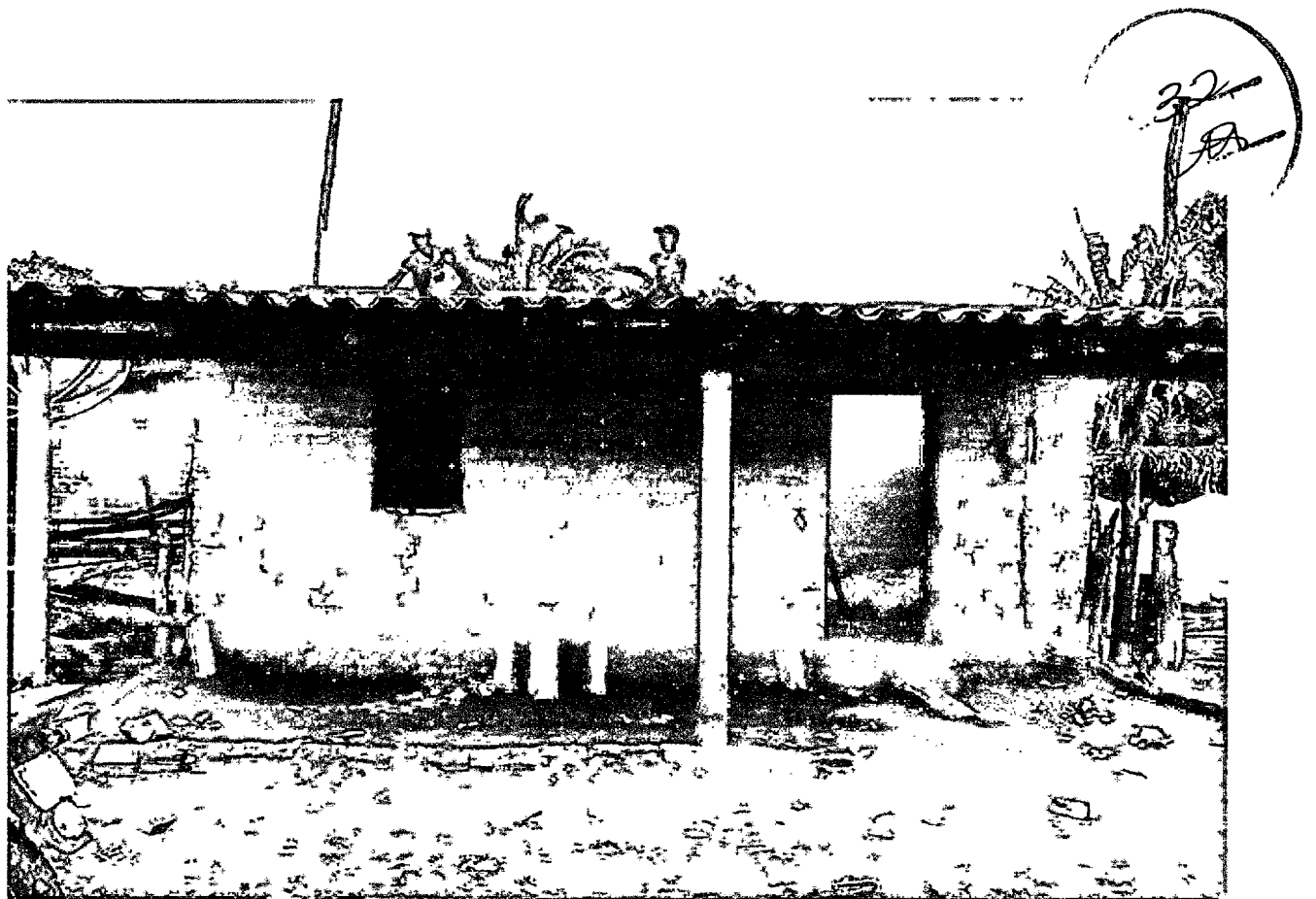
FOTO 11: Registro de casa com estrutura abalada e telhado destruído ocasionado pela chuva intensa, Povoado Carnaúba, dia 23/04/2020, Coordenadas: (Latitude: 3°36'1" S; Longitude: 42°59'47" W; Altitude: 70m)
