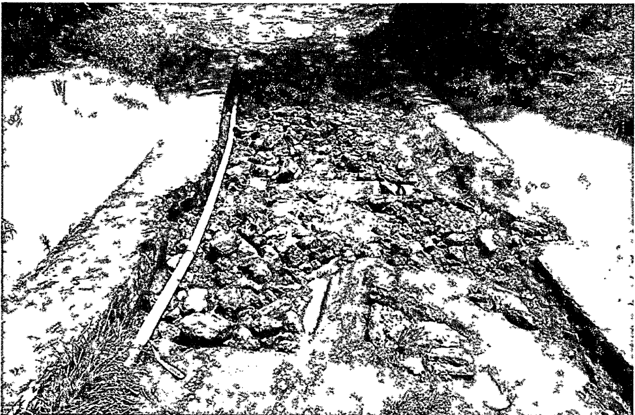
FOTO 60: Registro de ponte com estrutura abalada devido ao grande volume da água do rio provocado pela chuva intensa, Povoado Centro dos Otilios, dia 27/04/2020, Coordenadas: (Latitude: 3°42'8" S; Longitude: 43°2'10" W; Altitude: 90m)
