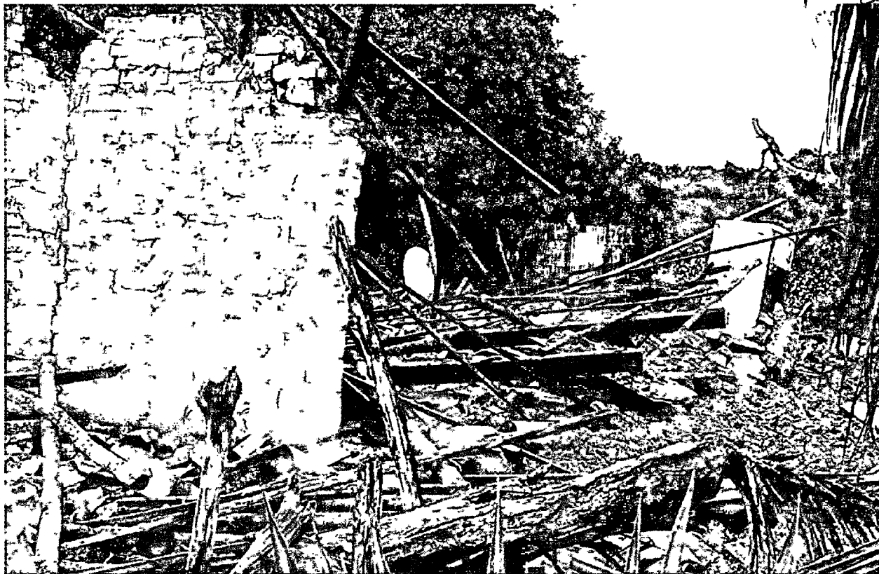
FOTO 17: Registro de casa destruída provocado pela forte chuva, Povoador Recanto, dia 23/04/2020, Coordenadas: (Latitude: 3°35'43" S; Longitude: 42°59'54" W; Altitude: 70m)
