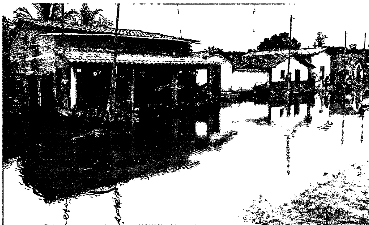
FOTO 54: Registro de estrada alagada e casas em situação de risco de desabamento e alagamento causada pela chuva intensa, Povoado Moraes II, dia 25/04/2020, Coordenadas: (Latitude: 3°32'5" S; Longitude: 43°4'54" W; Altitude: 60m)
