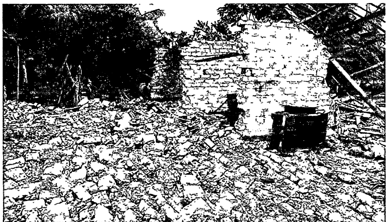
FOTO 20: Registro de casa destruída resultado da chuva intensa, Povoado Recanto, dia 23/04/2020, Coordenadas: (Latitude: 3°35'39" S; Longitude: 42°59'53" W; Altitude: 70m)
